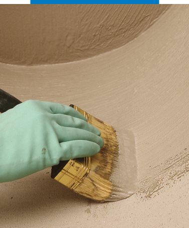
Στεγάνωση λεπτομερειών με πινέλο
